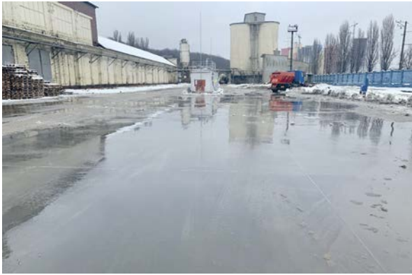
Рис. 9. Бетонна дорога київського терміналу
