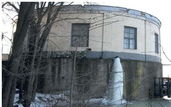
Рис. 1. Будівля насосної Кайдацької насосно-фільтрувальної станції м. Дніпро
