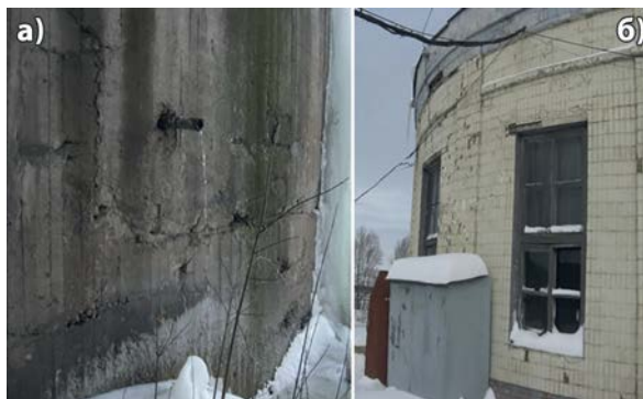
Рис. 2. Стіни підземної та наземної частини будівлі
