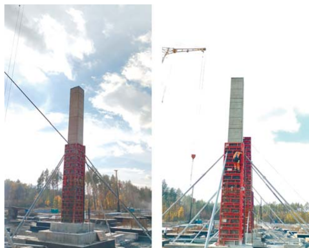
Рис 1. Фотографії виготовлення монолітних колон із високотехнологічного бетону (C32/40, SF2, F200, W8)
